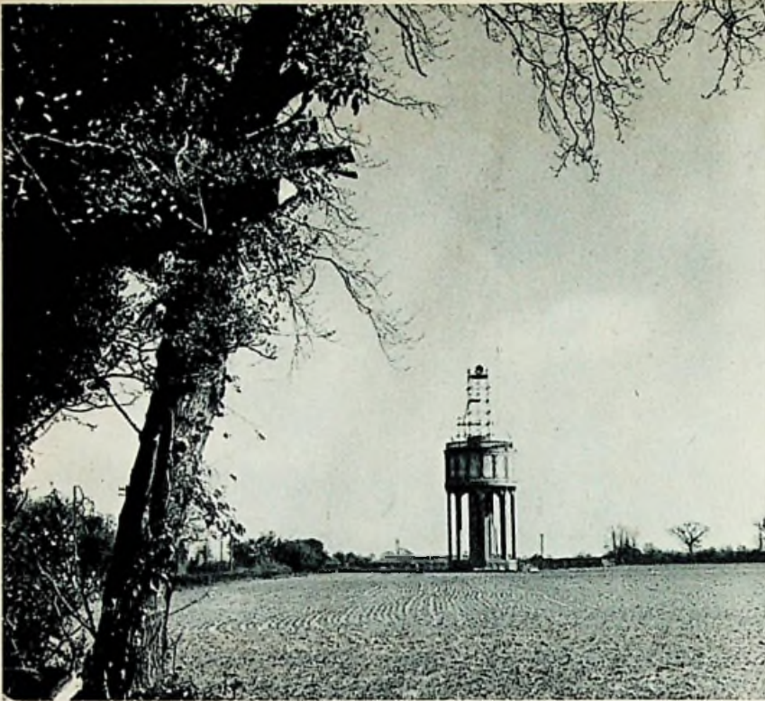
IDYLLISCH TUSSENPUNT LENHAM , pleisterplaats voor het TV-beeld tussen Londen en Wrotham (Dover). Zender en ontvanger, met een buizenconstructie verhoogd opgesteld, op een watertoren.
